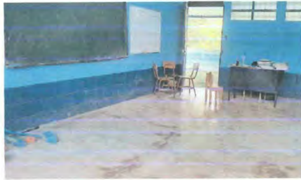
Foto 2: Piso: Vista interior del estado actual del piso de las aulas del módulo 1, el cual se sustituirá por piso cerámico.
