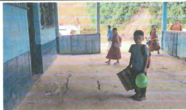
Foto 5: Estado actual del piso del área del corredor del módulo 1, en mal estado y que amerita intervención.
