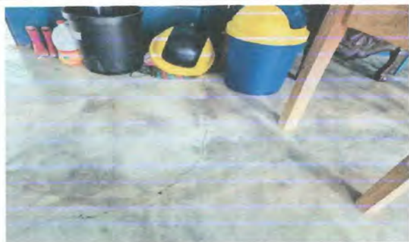
Foto 3: Piso de una de las aulas que será intervenido con la instalación de piso cerámico.
